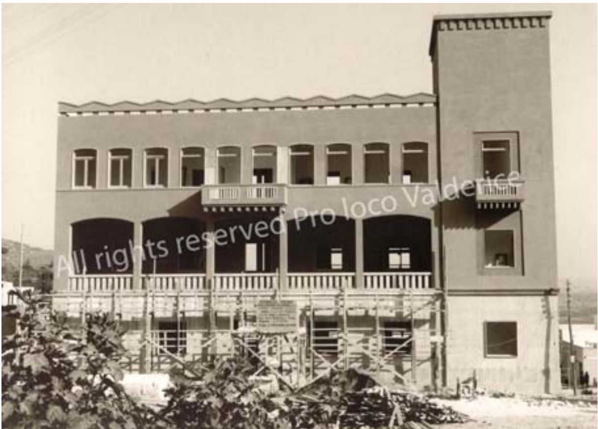
N° 292. Anno 1967 vengono tolte le ultime impalcature per la consegna del palazzo comunale dall'impresa A. Centurino che ha eseguito l'ultimo stralcio dei lavori.
