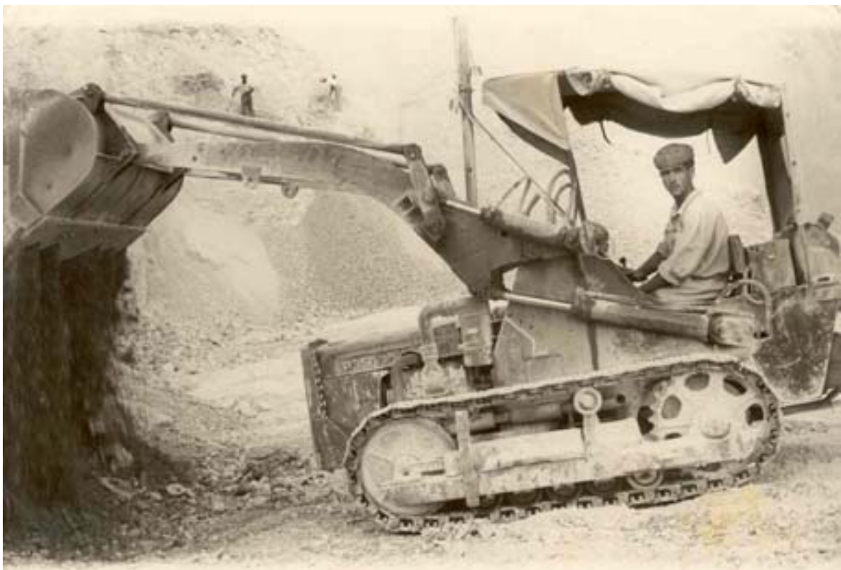
N°. 189. Mezzo meccanico per lavori di urbanizzazione. Anno 1959.
