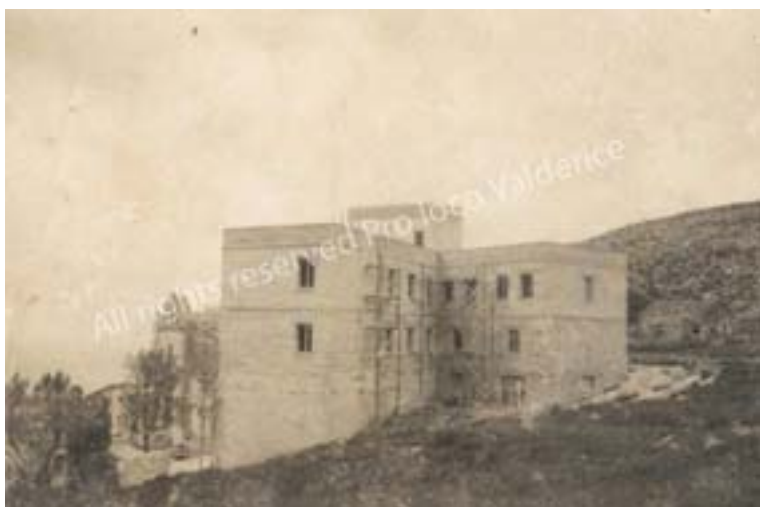
N° 255. Costruzione del seminario di Misericordia
